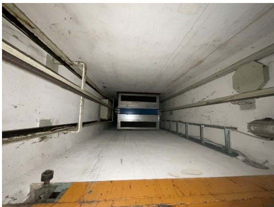
Foto Schacht Kleinlastenaufzug
