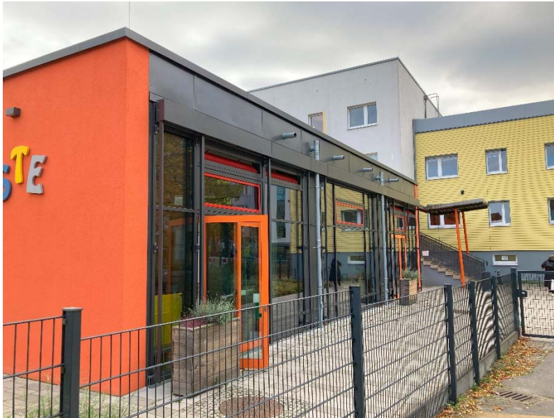
Foto Bestand, Kita Dr.-Otto-Nuschke-Str.1, 01809 Heidenau, NO-Seite, Anbau © Sucharski Architektur GmbH
