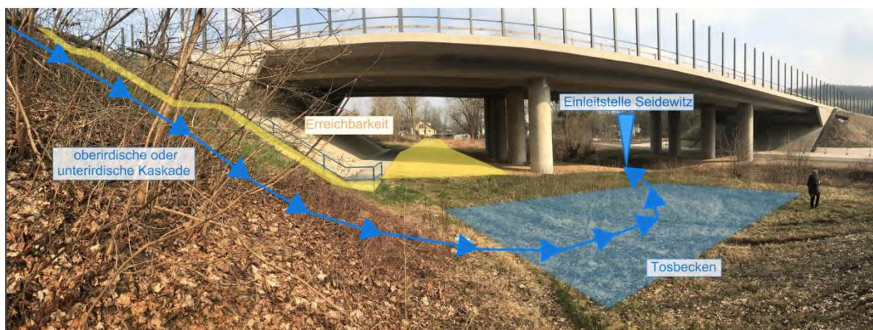
Abbildung 23 Veranschaulichung der Einordnung des Einleitbereichs in die Seidewitz, äußere Erschließung Variante AE 3a
