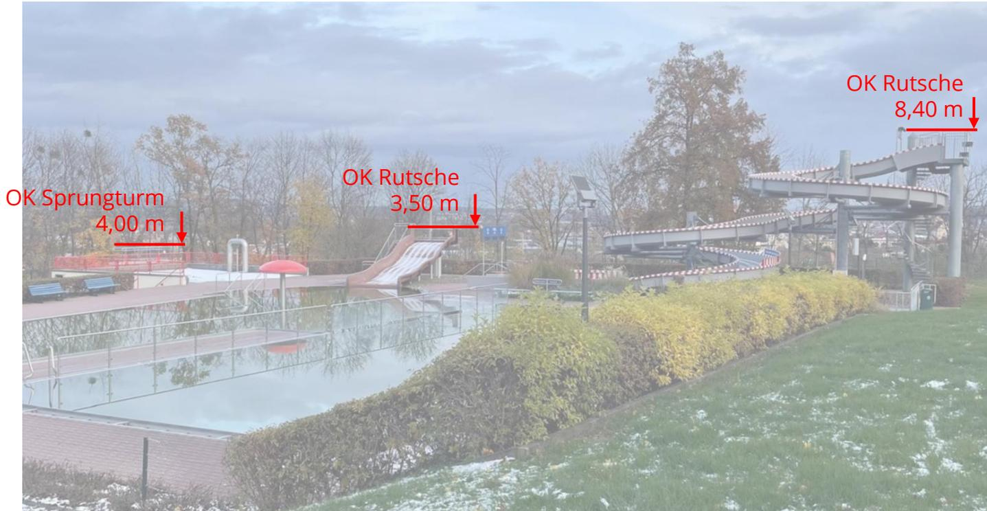
Höhen charakteristischer Elemente über Geländeoberkante für Verschattungssimulation und grafische Visualisierung der Anlage
