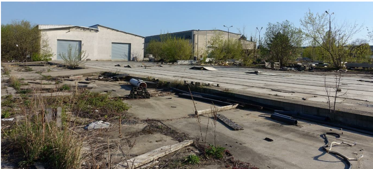
Abb. 9: Versiegelte Straßen- und Wegeflächen (11.04.100) im Zentrum des Plangebietes
