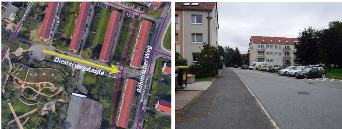
Abbildung 8: Lage und örtliche Verhältnisse Sanierungsabschnitt „Diesterwegstraße“
