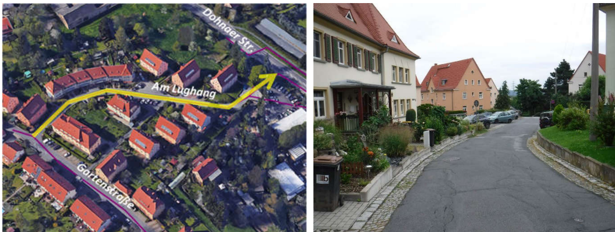
Abbildung 3: Lage und örtliche Verhältnisse Sanierungsabschnitt „Am Lughang“
