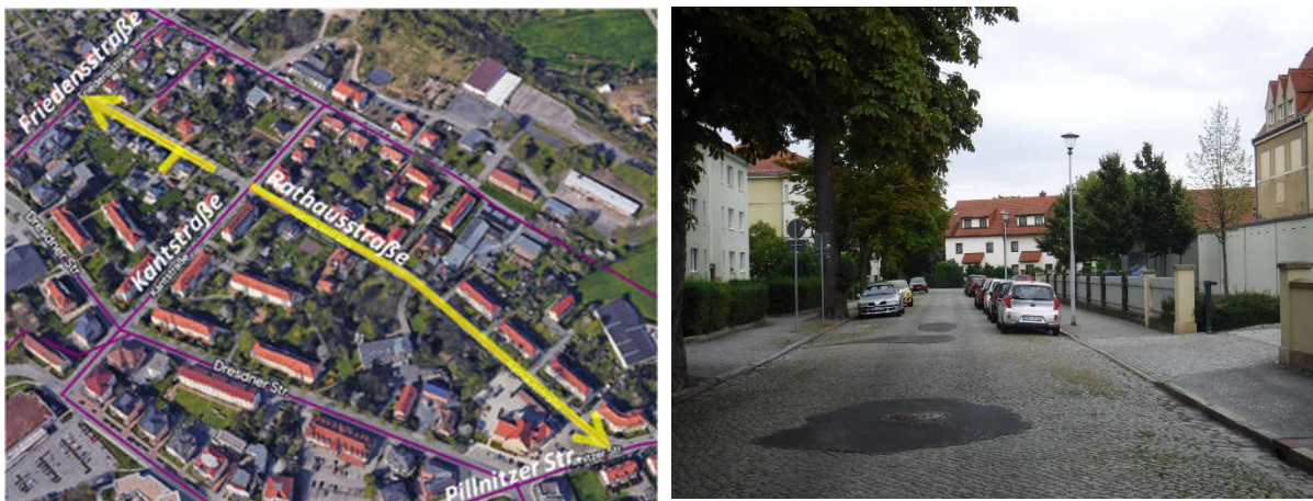
Abbildung 54: Lage und örtliche Verhältnisse Sanierungsabschnitt „Rathausstraße“
