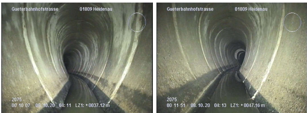
Abbildung 26: Richtungsänderungen (Bögen) in der Haltung 2075
