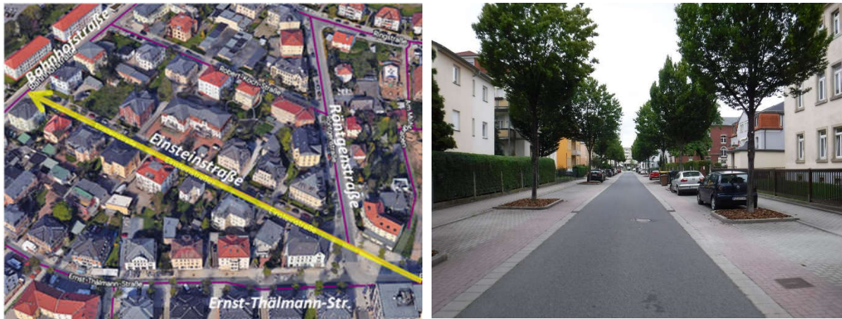
Abbildung 15: Lage und örtliche Verhältnisse Sanierungsabschnitt „Einsteinstraße“
