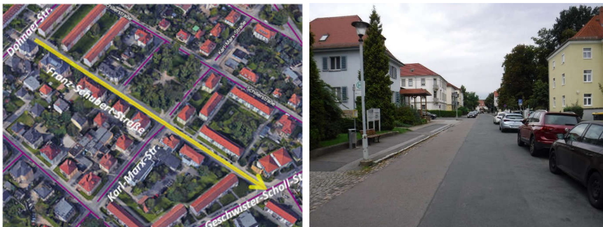
Abbildung 19: Lage und örtliche Verhältnisse Sanierungsabschnitt „Franz-Schubert-Straße“
