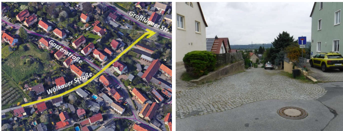
Abbildung 69: Lage und örtliche Verhältnisse Sanierungsabschnitt „Wölkauer Straße“
