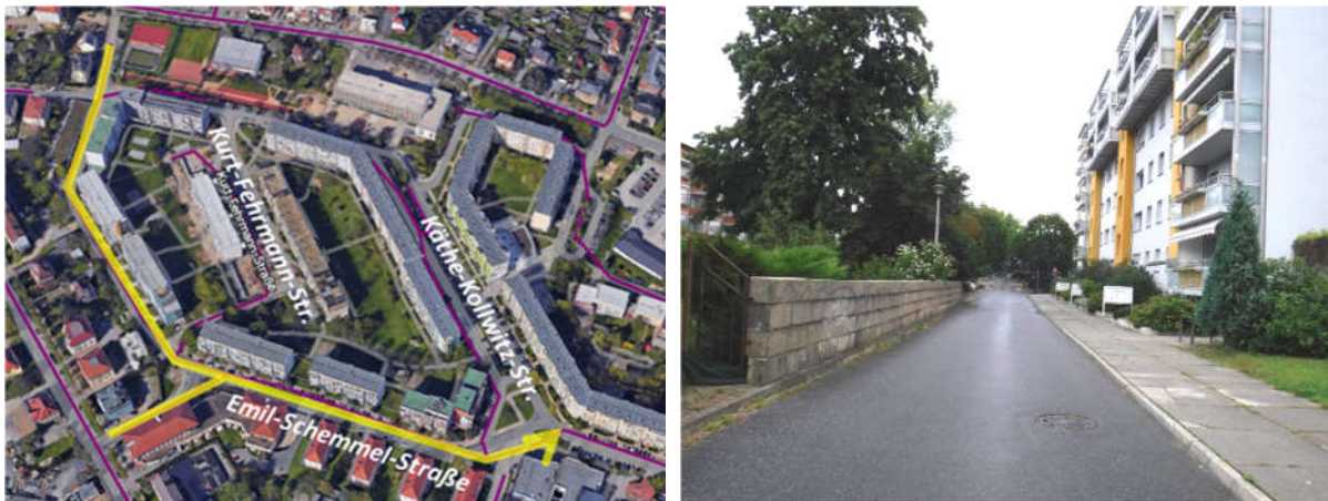
Abbildung 17: Lage und örtliche Verhältnisse Sanierungsabschnitt „Emil-Schemmel-Straße“
