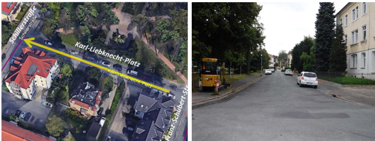
Abbildung 36: Lage und örtliche Verhältnisse Sanierungsabschnitt „Karl-Liebknecht-Platz“
