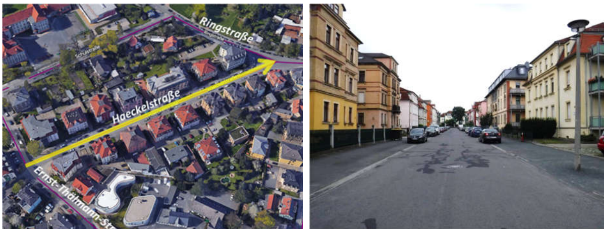
Abbildung 28: Lage und örtliche Verhältnisse Sanierungsabschnitt „Haeckelstraße“
