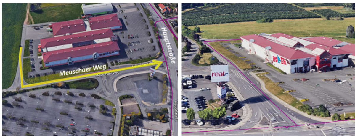
Abbildung 44: Lage und örtliche Verhältnisse Sanierungsabschnitt „Meuschaer Weg“
