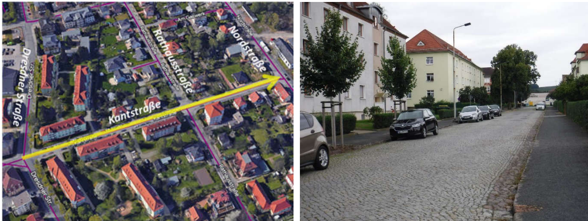
Abbildung 34: Lage und örtliche Verhältnisse Sanierungsabschnitt „Kantstraße“
