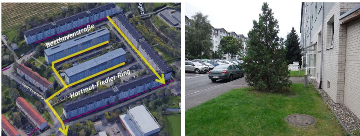
Abbildung 30: Lage und örtliche Verhältnisse Sanierungsabschnitt „Hartmut-Fiedler-Ring“
