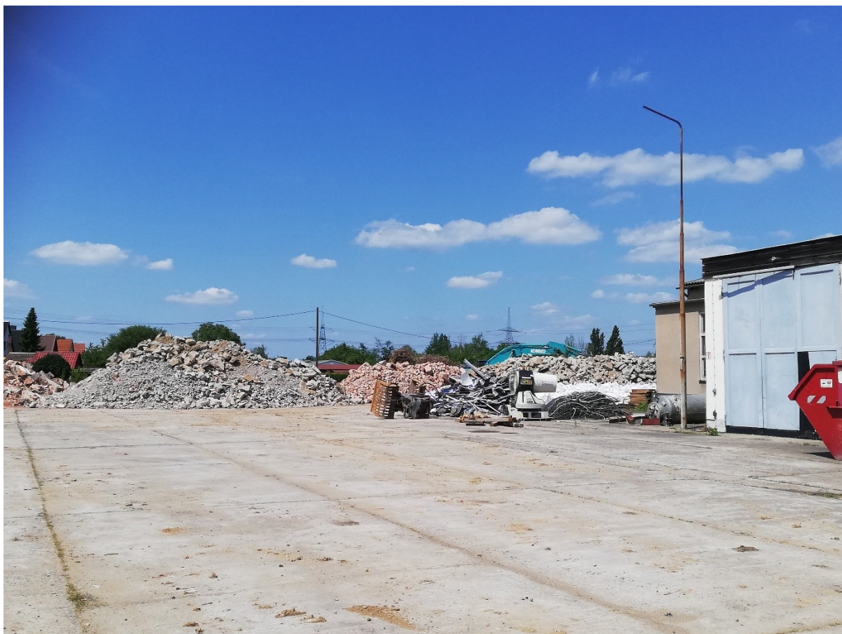
Abbildung 1: Abgerissenes Gebäude an der Hermann-Löns-Straße 1a
