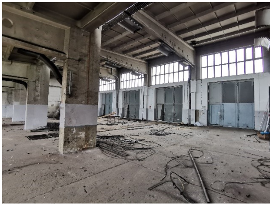
Abbildung 31: Werkstatt; Innenbereich und entfernte Leitungen
