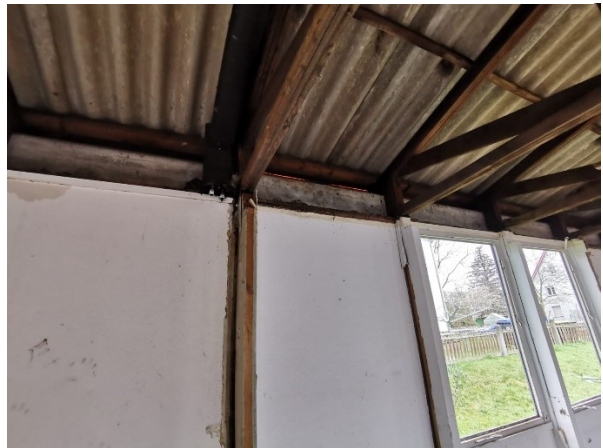
Abbildung 16: Dachstuhl mit Wellblechdach
