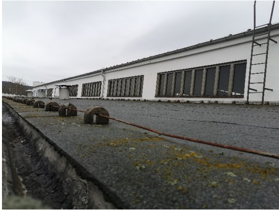
Abbildung 29: Werkstatt; abgestuftes Flachdach
