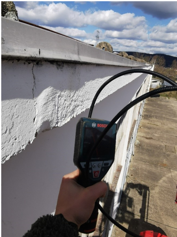
Abbildung 13: Endoskop zur Überprüfung der Attika
