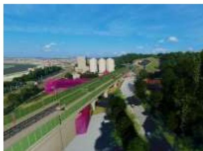
Abb. 8: Überführung S 172 am Tunnelportal
