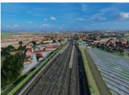
Abb. 7: Bahnhof Heidenau (Sachs)
