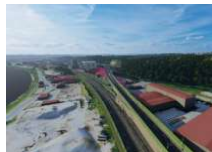
Abb. 9: Rampe zum Tunnelportal Heidenau
