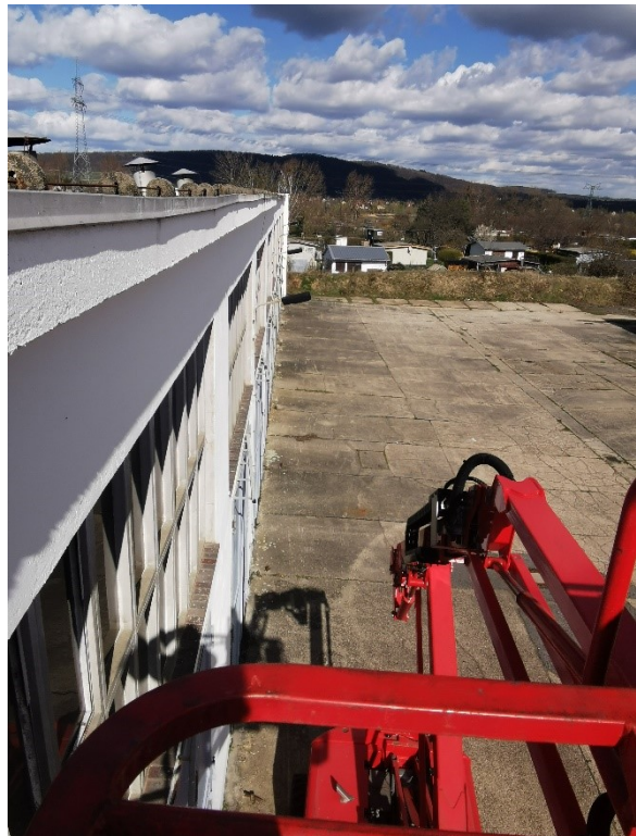
Abbildung 14: Blick vom Hubsteiger
