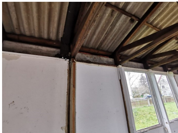
Abbildung 16: Dachstuhl mit Wellblechdach
