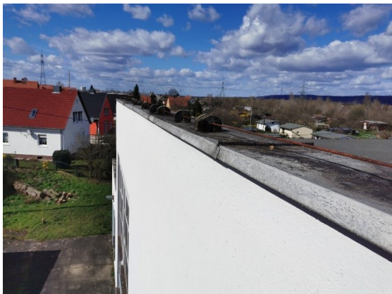
Abbildung 9: Blick vom Hubsteiger auf Attika
