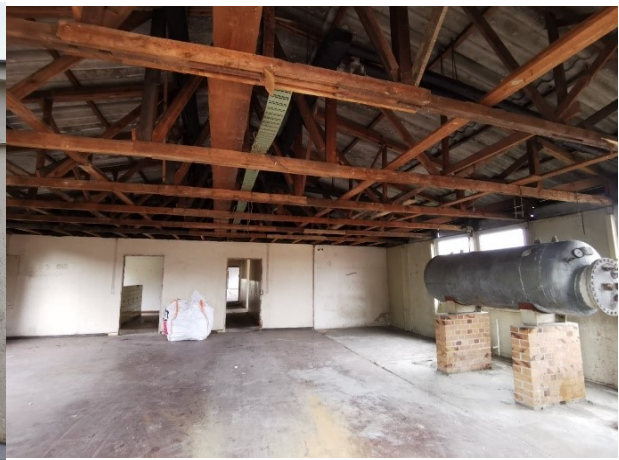
Abbildung 14: Innenbereich mit Blick auf Dachstuhl
