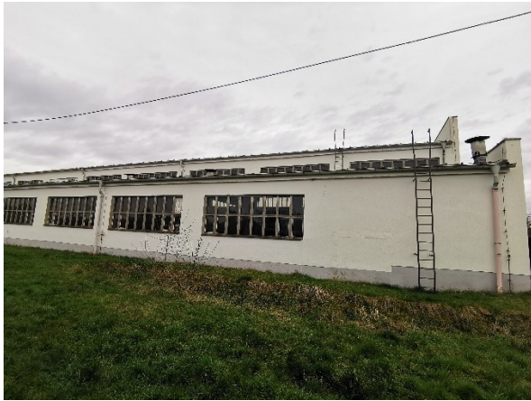
Abbildung 25: Werkstatt; Westliche Fassade
