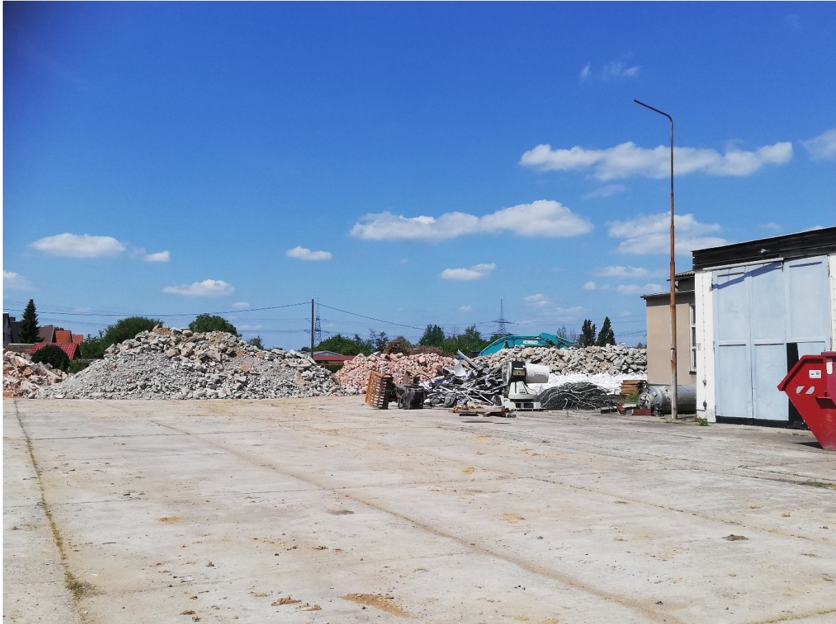
Abbildung 1: Abgerissenes Gebäude an der Hermann-Löns-Straße 1a
