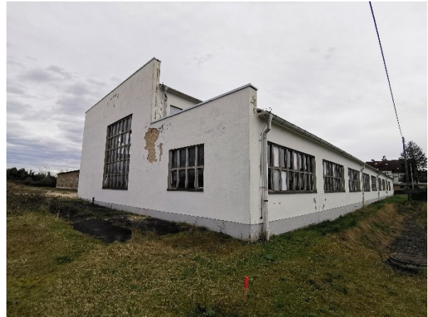
Abbildung 26: Werkstatt; Nördliche Fassade
