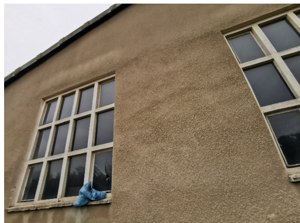
Abbildung 38: Lagerhalle; ausgeschäumtes Fenster
