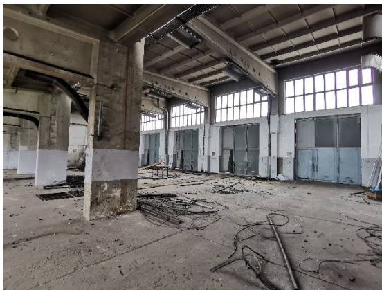
Abbildung 31: Werkstatt; Innenbereich und entfernte Leitungen
