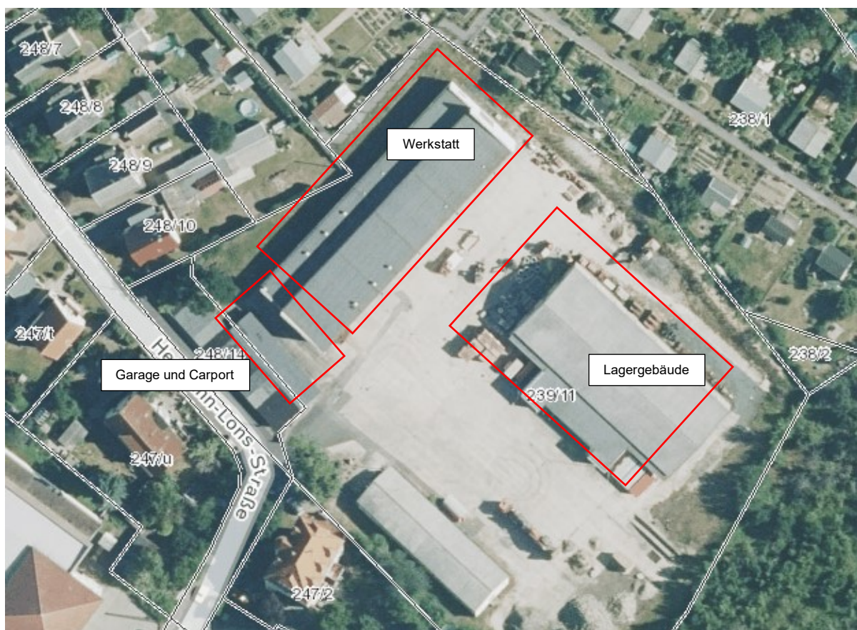
Abbildung 2: Luftbild mit Verortung der Abrissgebäude
