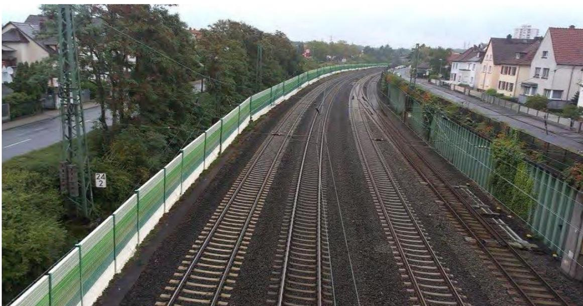
Foto: Beispiel für Lärmschutz entlang einer Haupteisenbahnstrecke
