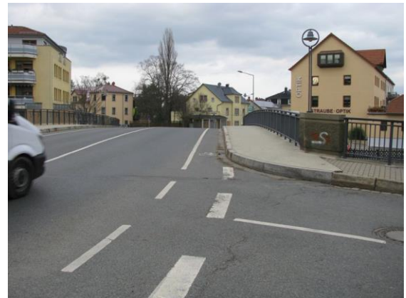
Foto: Radführung Max-Walther-Brücke von Pirnaer Straße
