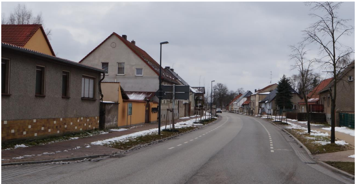
Foto: sanierter und Fahrrad-freundlich umgestalteter Straßenabschnitt in Berge
