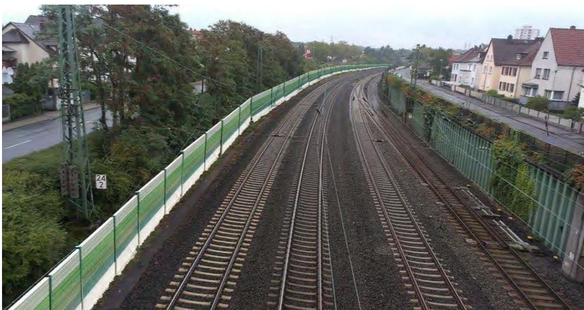
Foto: Beispiel für Lärmschutz entlang einer Haupteisenbahnstrecke
