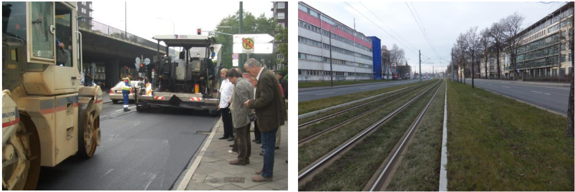
Fotos: Einbau lärmindernder Belag in Düsseldorf, Rasengleis Zwickauer Straße Chemnitz
