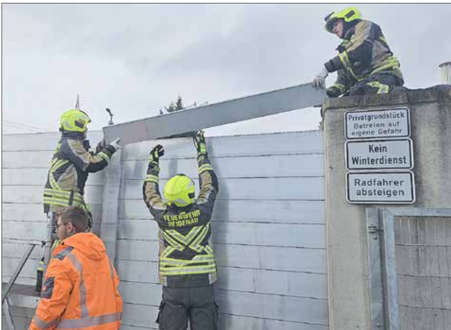
Aufbau der Mobilen Hochwasserschutzanlage am Durchgang zum Biergarten der Villa Else Foto: FFW Heidenau
