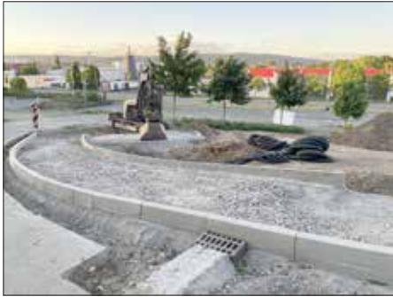
Erneuerung der Zuwegung zum Albert-Schwarz-Bad Foto: Bad
