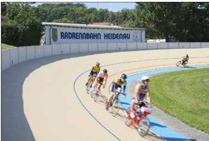
Erste Proberunden auf der sanierten Radrennbahn
