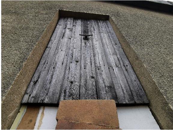
Abbildung 15: Geschlossene Öffnung des Dachbodens
