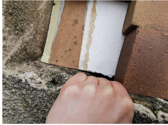
Abbildung 16: Geschlossener Dachboden; Nahaufnahme
