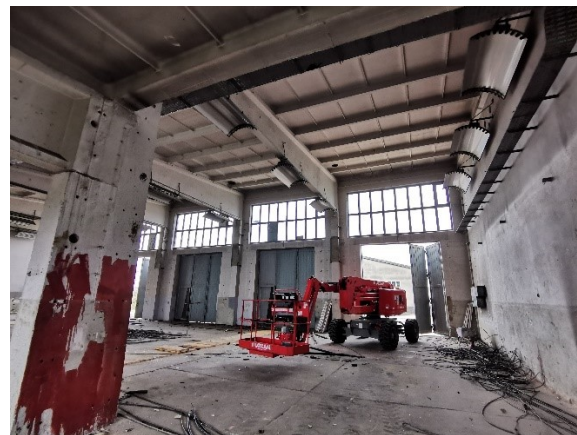
Abbildung 32: Werkstatt; Innenbereich und Hubsteiger
