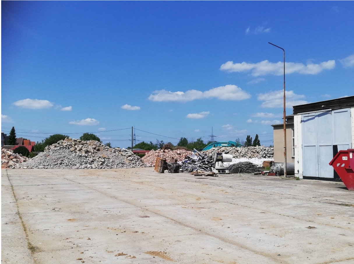
Abbildung 1: Abgerissenes Gebäude an der Hermann-Löns-Straße 1a
