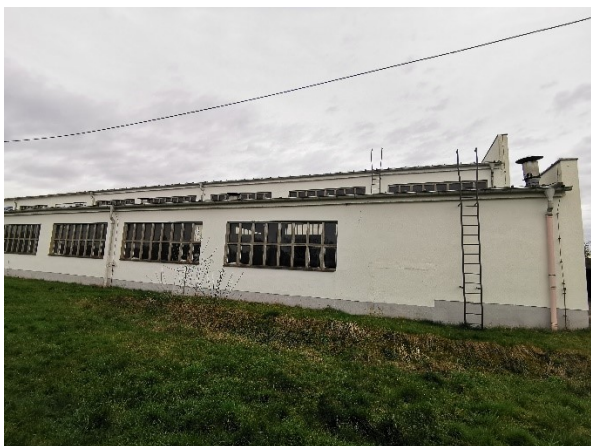
Abbildung 25: Werkstatt; Westliche Fassade
