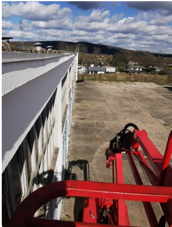
Abbildung 14: Blick vom Hubsteiger
