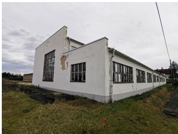
Abbildung 26: Werkstatt; Nördliche Fassade
