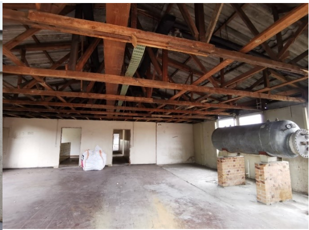
Abbildung 14: Innenbereich mit Blick auf Dachstuhl
