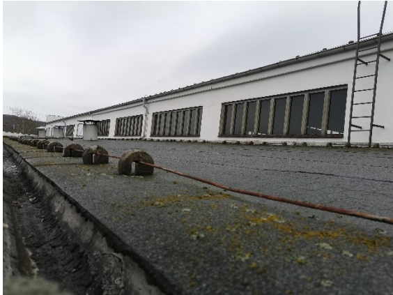
Abbildung 29: Werkstatt; abgestuftes Flachdach
