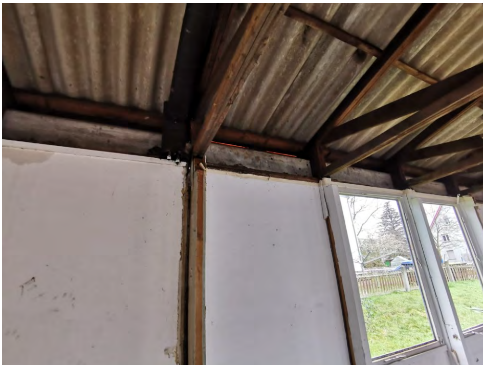
Abbildung 6: Dachstuhl und Wellblechdach
