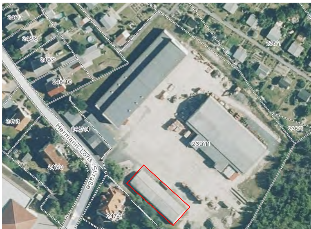
Abbildung 2: Luftbild mit Verortung des Abrissgebäudes "Bürobaracke" (rot)
