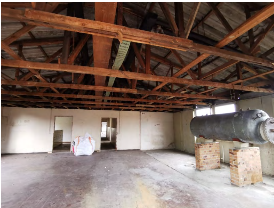
Abbildung 4: Innenbereich mit Blick auf Dachstuhl
