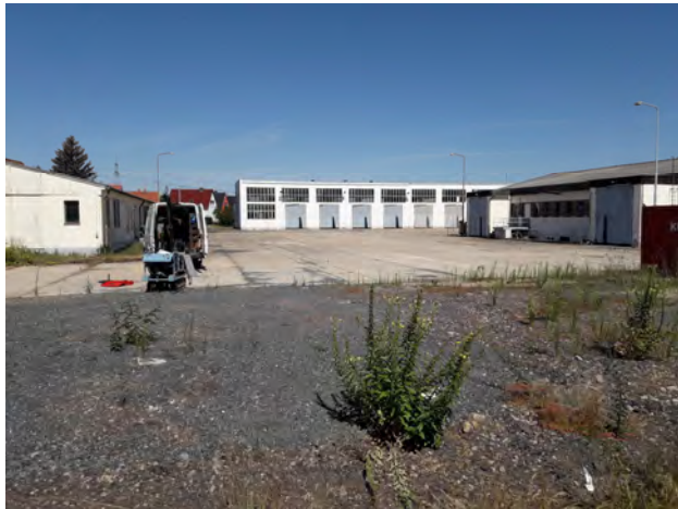
Abbildung 1: Übersicht Baugrundstück, Blick Richtung Nord-Nordwest, 26.07.2022
