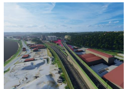
Abb. 9: Rampe zum Tunnelportal Heidenau
