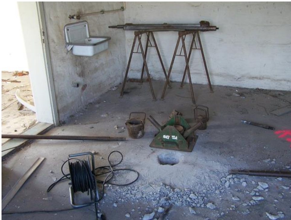
Bild 9: abgebrochende Sondierbohrung im Nebengebäude 1 aufgrund des massiven Betons (kein Baufortschritt)
