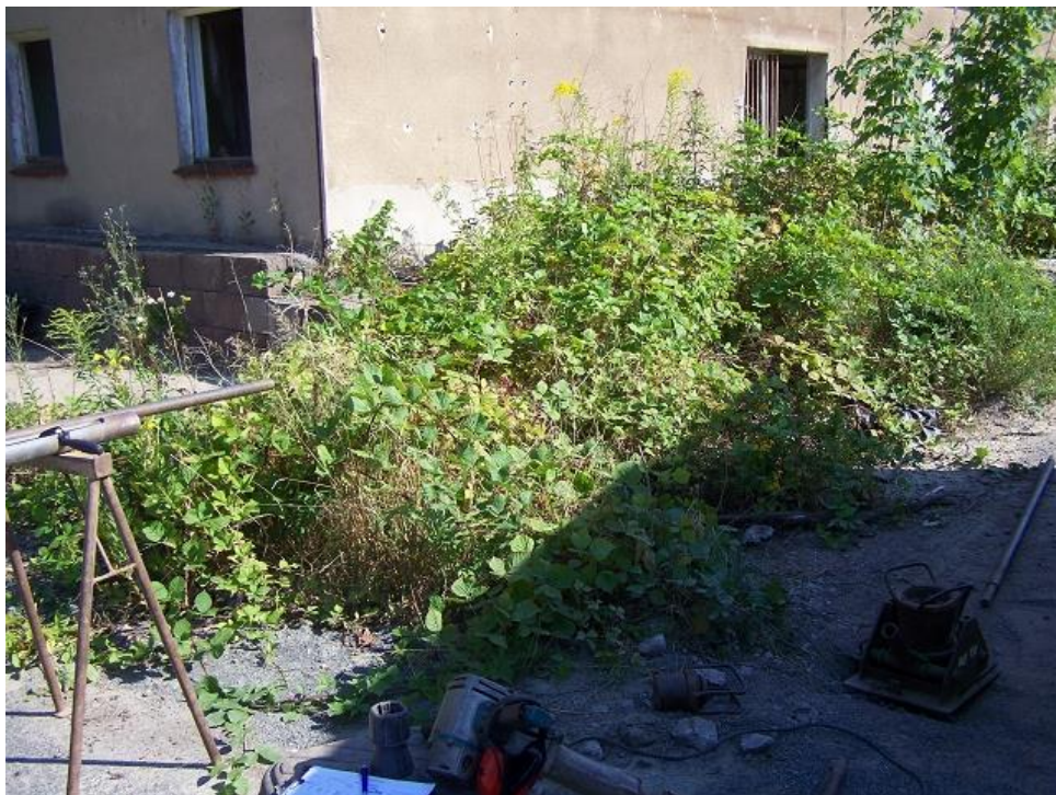
Bild 10: RKS 05/14 vor dem Nebengebäude 1 abgeteuft
