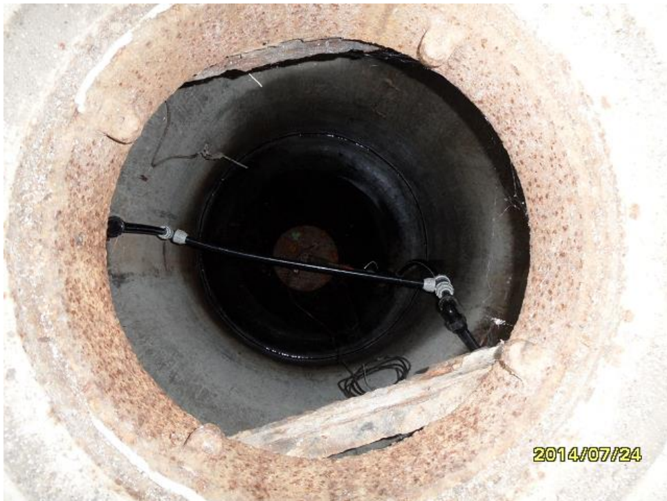
Bild 24: Blick von oben in den geöffneten Brunnen
