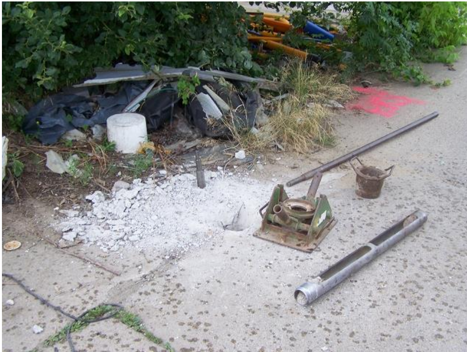
Bild 15: RKS 09/14 an der nordwestlichen Giebelseite der Produktionshalle H12- ALF 1 (30 cm Stahlbetonversiegelung)
