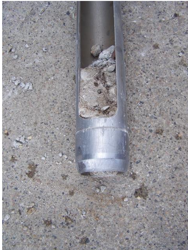
Bild 14: RKS 08/14, 35 cm Stahlbetonversiegelung
