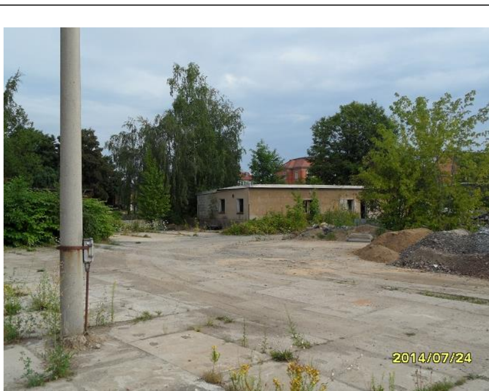
Bild 8: RKS 05/14 Blick von Süden auf die ALF 2 Nebengebäude 1
