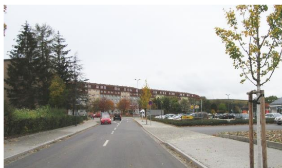
Foto: Zufahrt Plangebiet (Planstraße Ost) an der Gabelsbergerstraße
