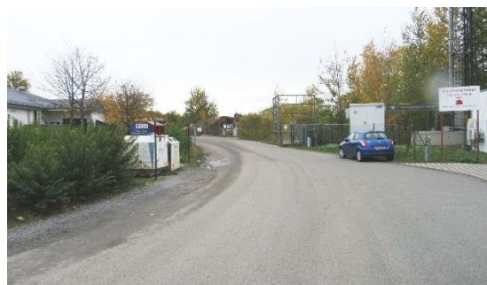
Foto: weiterer Verlauf der Erschließungsstraße
