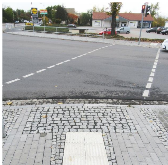
Foto: Querung Gabelsbergerstraße (an S 172), trotz taktiler Elemente nicht barrierefrei
