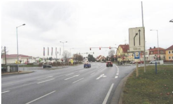
Foto: KP 5, S 172 Hauptstraße/ Güterbahnstraße, Fahrtrichtung nach Nordwesten
