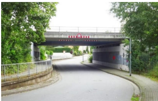
Foto: Bahnunterführung Mühlenstraße, lichte Höhe 3,80 m
