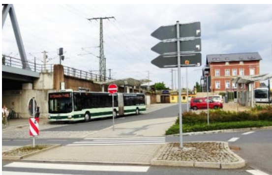
Foto: Zugang zum Bahnhof Heidenau
