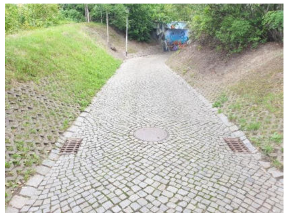
Foto: gemeinsamer Geh- und Radweg zur Unterführung, starkes Gefälle
