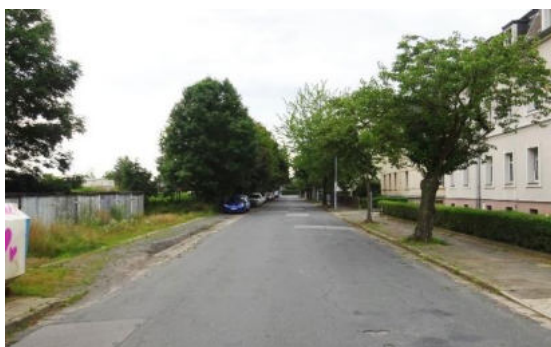
Foto: einseitig fehlender Gehweg, Nordseite der Heinrich-Heine-Straße
