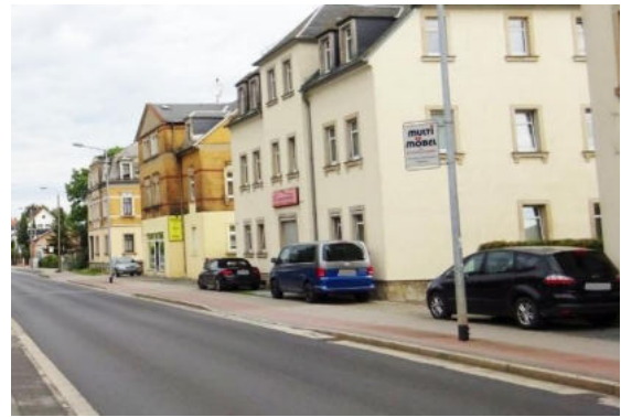
Foto: ca. 2,50 m Gehweg („Rad frei“), Lichtmast auf rotem Pflaster und rechtsseitig parkende Kfz, nördlich der Mühlenstraße
