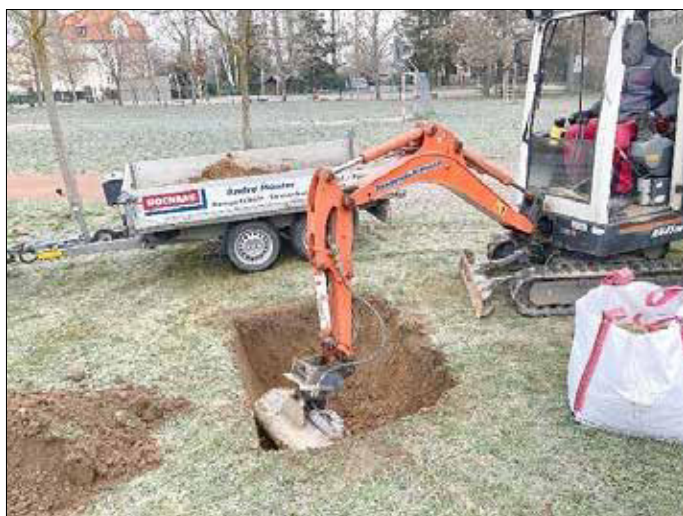
Aushub der Grube am Sportplatz Gr. Sedlitz
