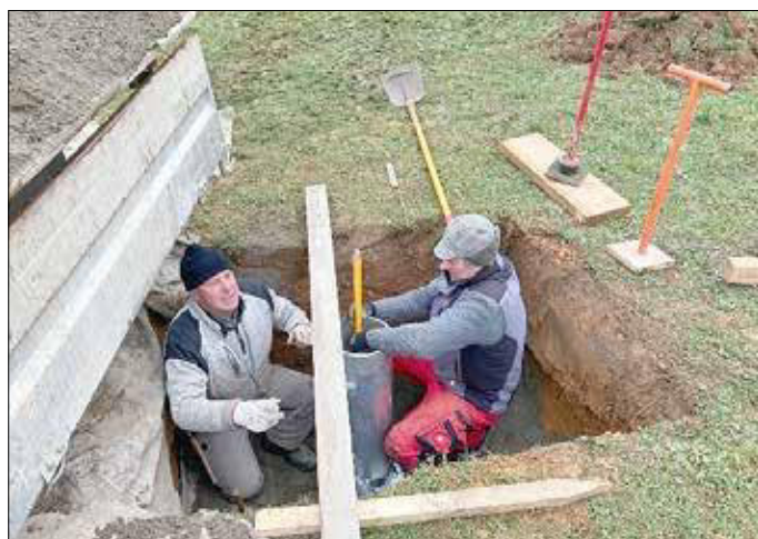
Einbetonieren der gespendeten Hülse von Stahlbau May durch die Bauunternehmen André Münter und Lars Gebler
