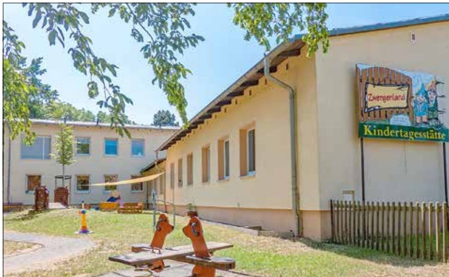
Auch die Kita „Zwergenland“ erhält ein neues Heizsystem.
