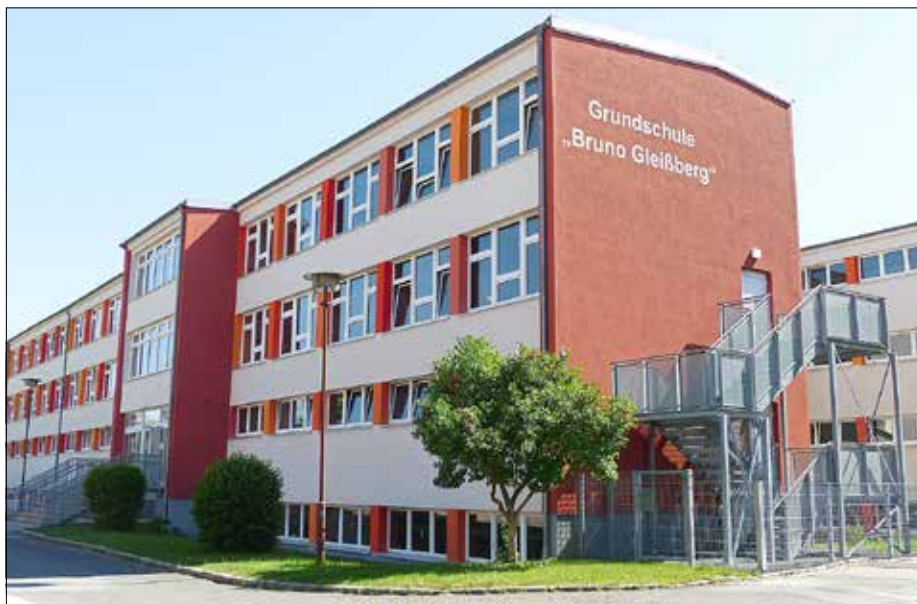
In der Grundschule „Bruno Gleißberg“ wird das gesamte Heizsystem erneuert.
