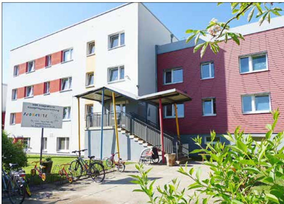
Die Sanierung und Erweiterung erfolgt in diesem Jahr in der Kita „Flohkiste“ - Fotos: Stadt Heidenau
