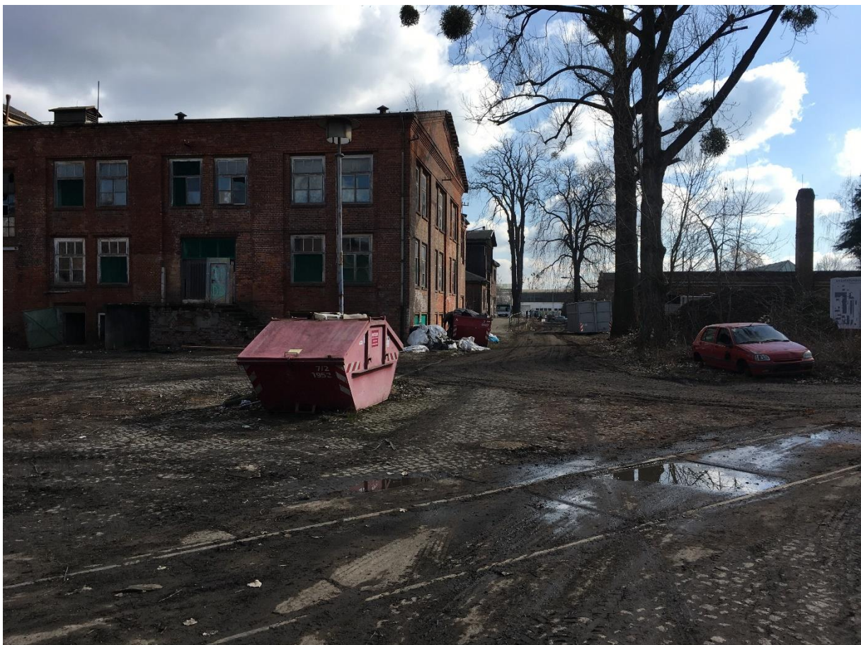
Abbildung 6: Blick auf ein verfallenes Gebäude, flächige Versiegelung und die ehemaligen Gleise.
