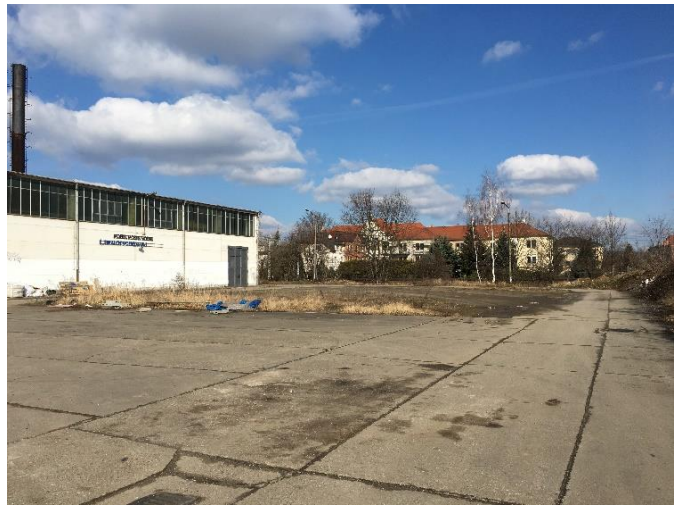
Abbildung 5: Versiegelungen und Brachfläche/Lagerfläche.
