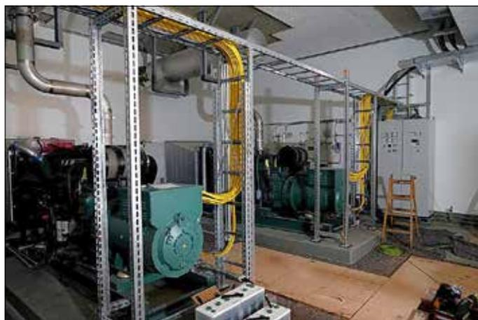
*Die Dieselgeneratoren, welche im Fall eines Starkregenereignisses die Pumpen antreiben.*
