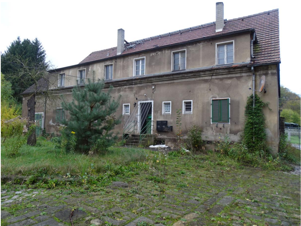
Anlage 2.5 – Bild Darstellung Gebäudezustand Mehrfamilienhaus
