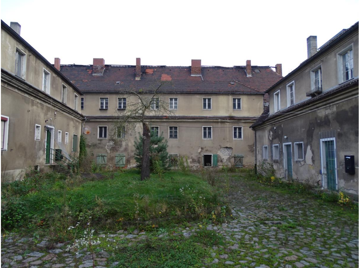
Anlage 2.4 – Bild Innenhof
