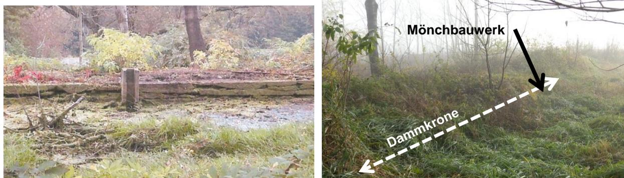
Abbildung 1-4: Absperrbauwerk des Teiches oberhalb des Wasserlaufes Briefträgerweg nach Teichentleerung im Oktober 2010 (links; Quelle: Stadt Heidenau) und im November 2012 (rechts)
