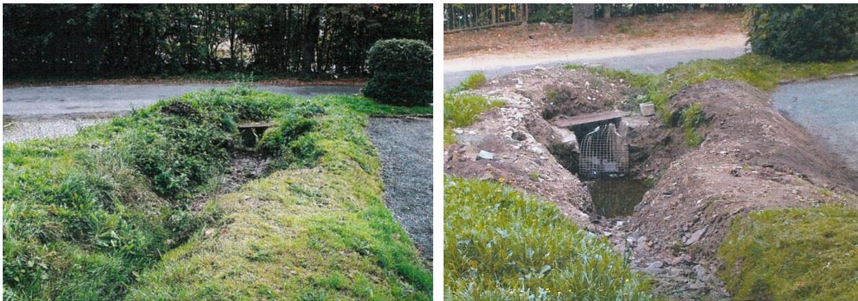
Abbildung 1-2: Ausspülungen am Einlaufbauwerk des Briefträgerweges an der Waldstraße vor (links) und nach (rechts) dem Hochwasserereignis 2010
