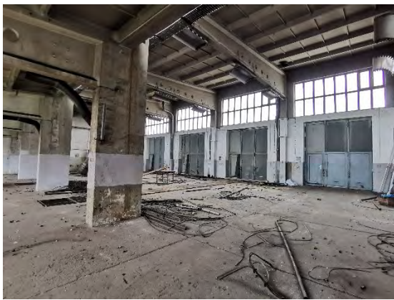
Abbildung 13: Werkstatt; Innenbereich und Entfernte Leitungen
