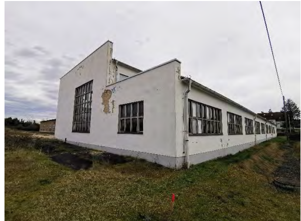
Abbildung 8: Werkstatt; Nördliche Fassade
