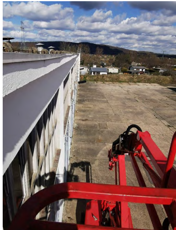
Abbildung 30: Blick vom Hubsteiger
