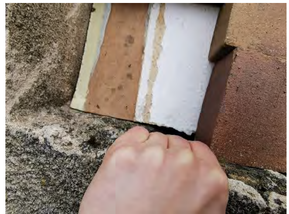
Abbildung 32: Geschossener Dachboden; Nahaufnahme
