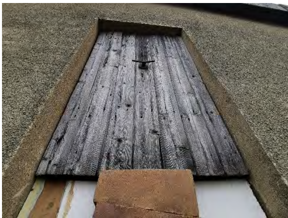
Abbildung 31: Geschlossene Öffnung des Dachbodens
