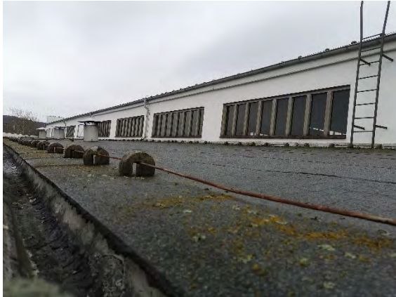
Abbildung 11: Werkstatt; Abgestuftes Flachdach
