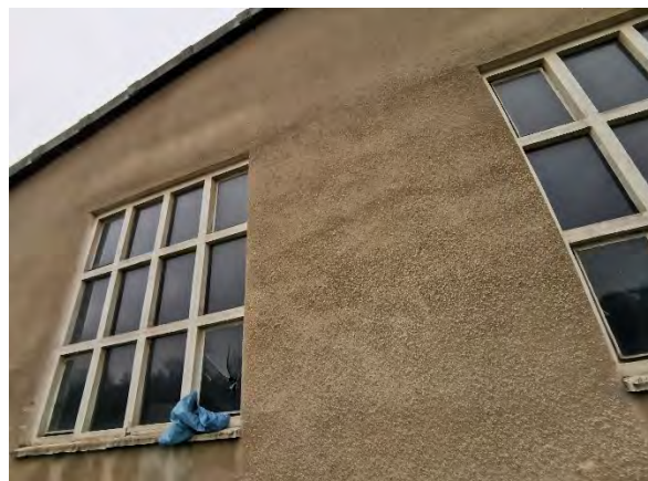
Abbildung 20: Lagerhalle; ausgeschäumtes Fenster
