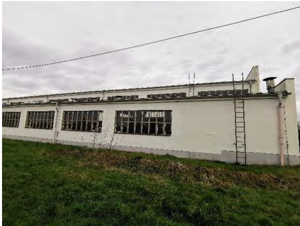
Abbildung 7: Werkstatt; Westliche Fassade
