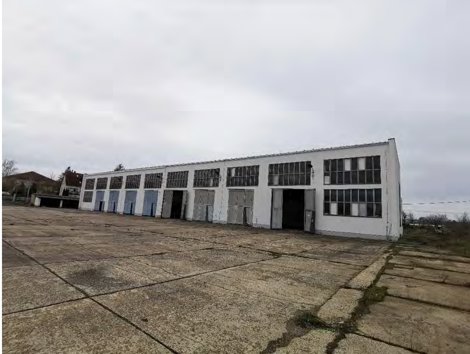
Abbildung 1: Lagerhalle an der Hermann-Löns-Straße 1a
