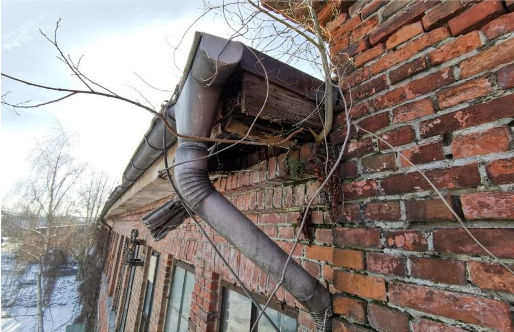
Abb. 22: Gebäude 4 Dachkasten südlicher Teil mit Mauerraute
